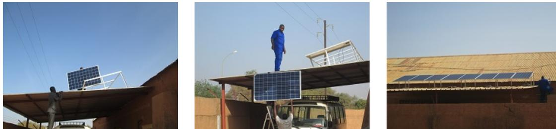
Installation des Panneaux Solaires Monocristallins sur la toiture d'une école militaire
